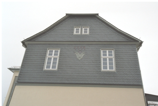
Beispiel für eine Fassadenverkleidung mit Naturschiefer „Alte Schule“ in Weilrod- Hasselbach
