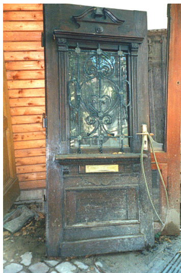
historische Tür vor Aufarbeitung
