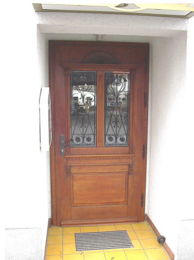
Tür nach Aufarbeitung und Einbau
