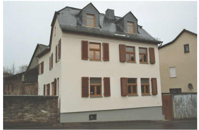
nach der Sanierung Wohnhaus in Hünfelden
