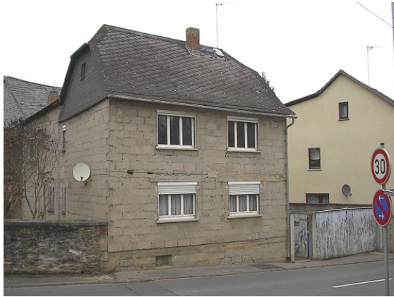
Beispiel: vor der Sanierung Wohnhaus in Hünfelden
